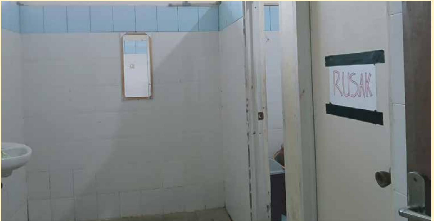
Kondisi Toilet Gedung KT Lantai dua kampus 1 PNUP [SA/476]
