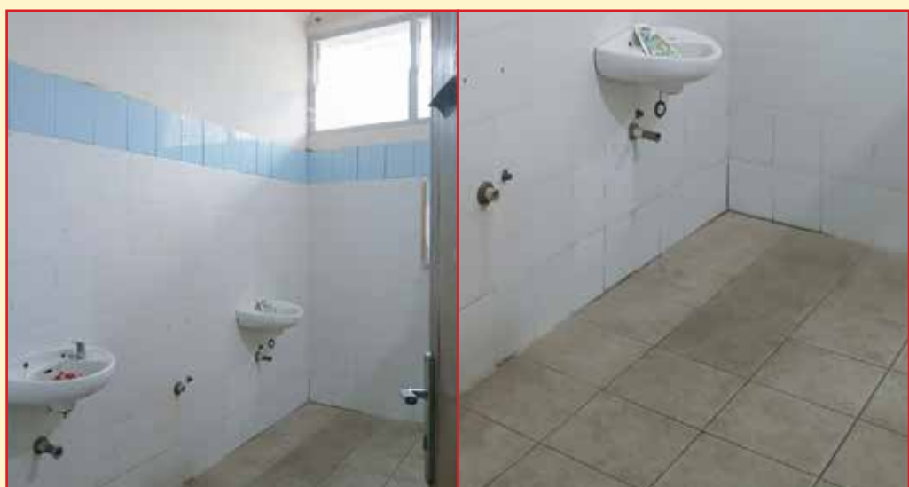
Kondisi Toilet Gedung KT Lantai dua kampus 1 PNUP [SA/476]
